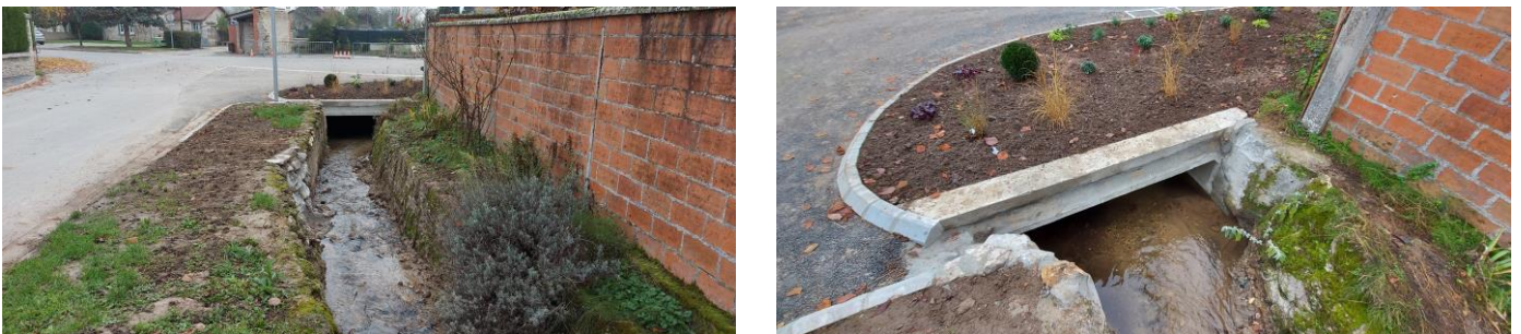
Figure 10 : Travaux réalisés en octobre 2020
